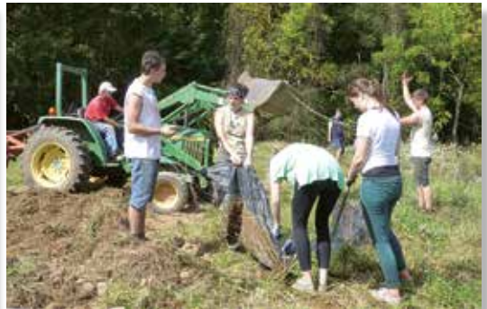
Schweißtreibende Arbeit beim Hausbauprojekt „Habitat for humanity“, 2014
